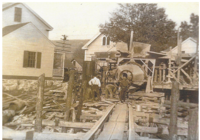
Pouring concrete, summer 1908
